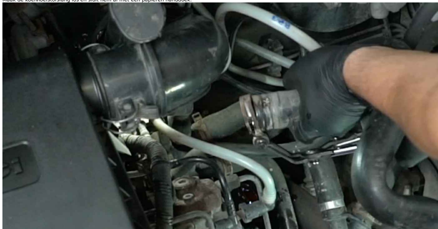
11 Reinig de bevestigingen van de kap van de thermostaatbehuizing. Gebruik een staalborstel. Gebruik een universele reinigingsspray.
